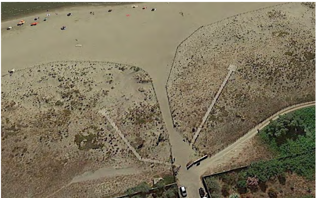
GoogleEarth – particolare passerelle
